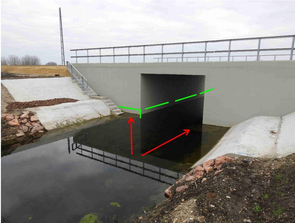
3. ábra: Vidrák és egyéb emlősök számára kedvezőbb műszaki kialakítású híd egy állandó vízzel ellátott csatornán.
