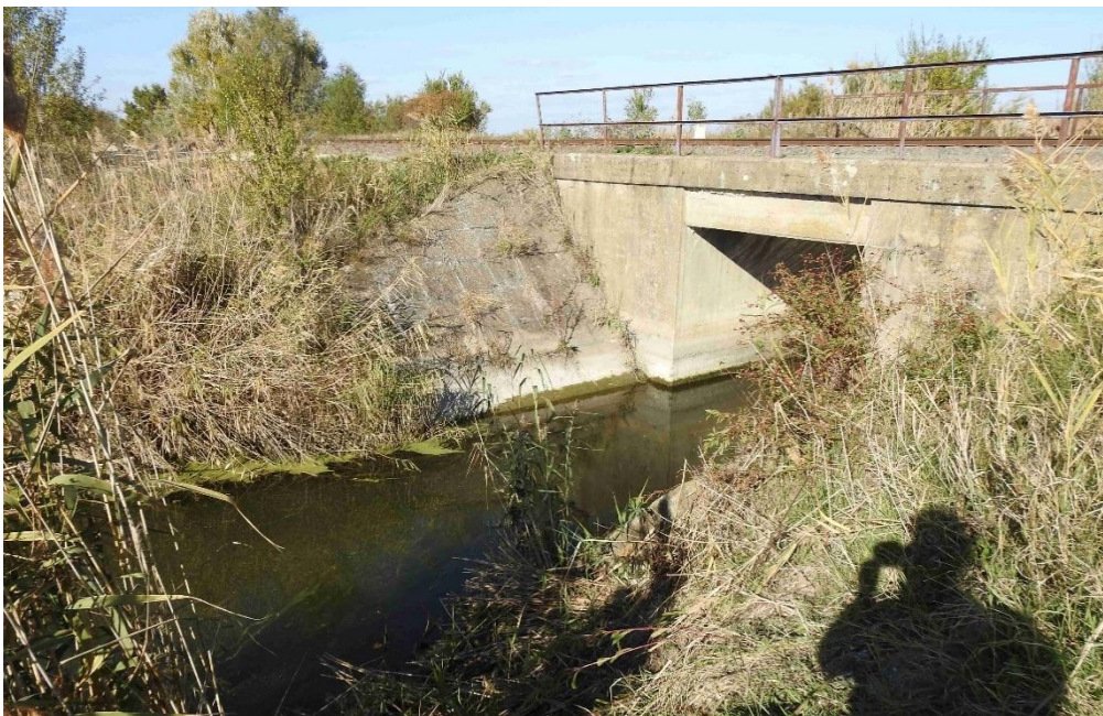
2. ábra: Vidrák és egyéb emlősök számára kevésbé alkalmas műszaki kialakítású híd egy állandó vízzel ellátott csatornán. Meredek a rézsű, továbbá hiányzik a száraz átkelést biztosító padka.
